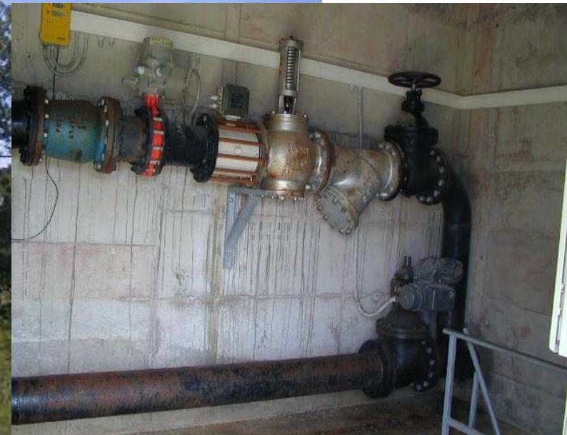
Particolare valvola regolatrice dei carichi
