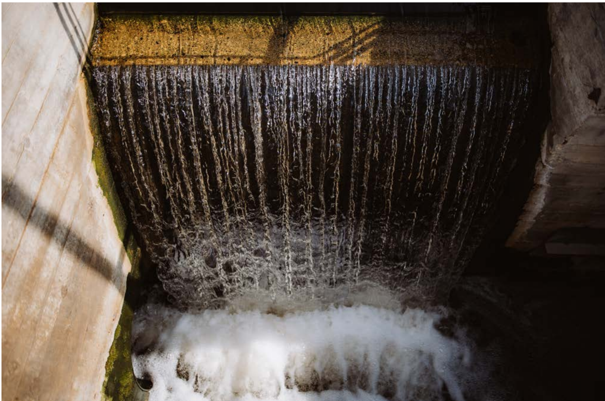
Acqua in uscita dall'impianto di depurazione
