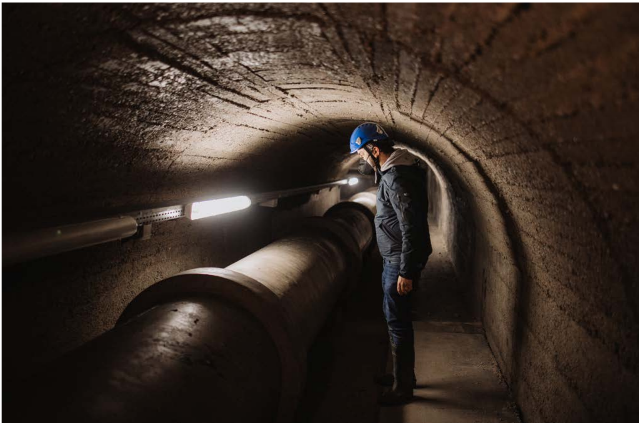
Tecnico del servizio adduzione all'interno della galleria della sorgente Pescara del Tronto.
