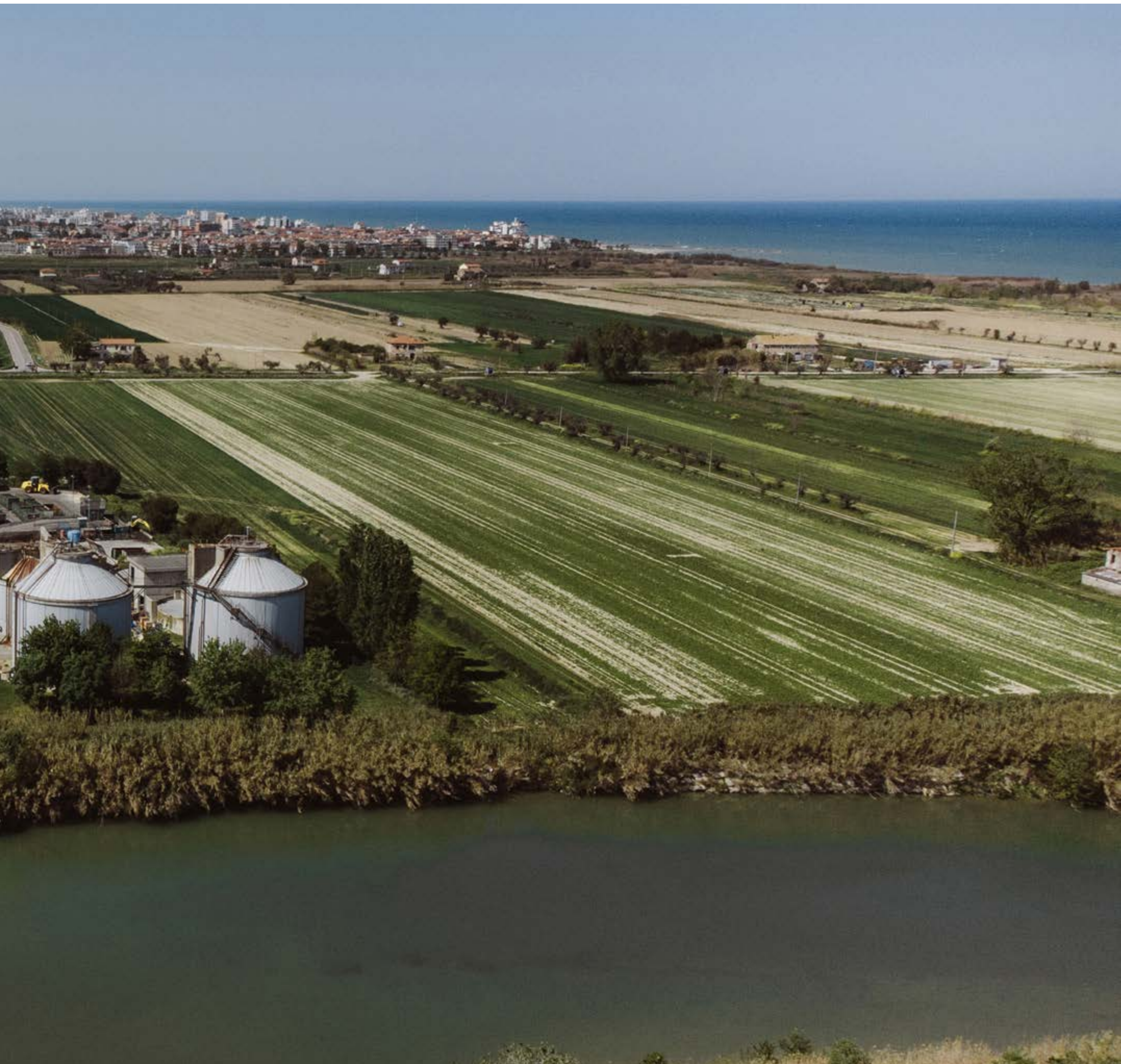
Impianto di depurazione Brodolini, San Benedetto del Tronto.
