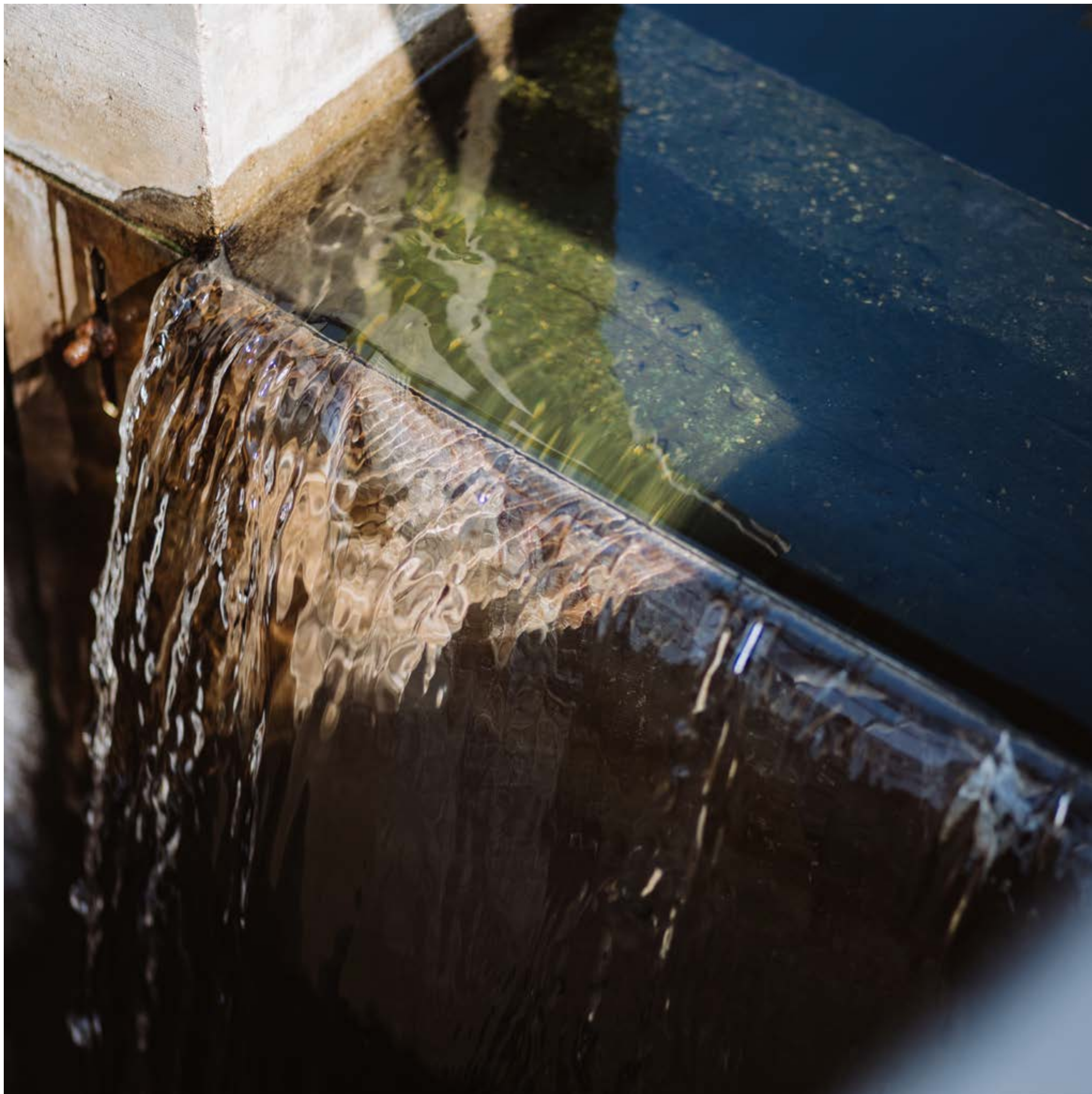
A fianco e in alto: acqua in uscita dall'impianto di depurazione Brodolini
