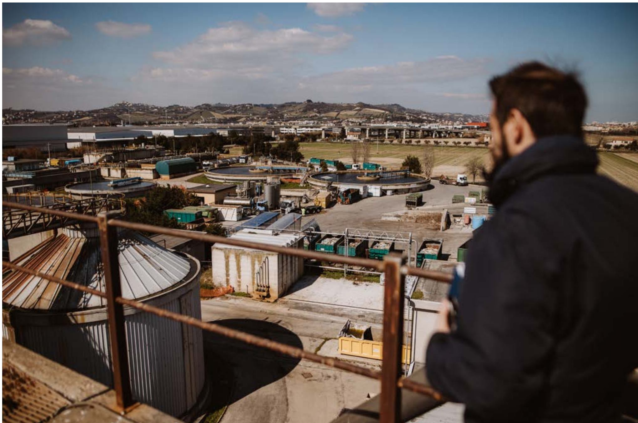
Impianto di depurazione Brodolini, San Benedetto del Tronto.
