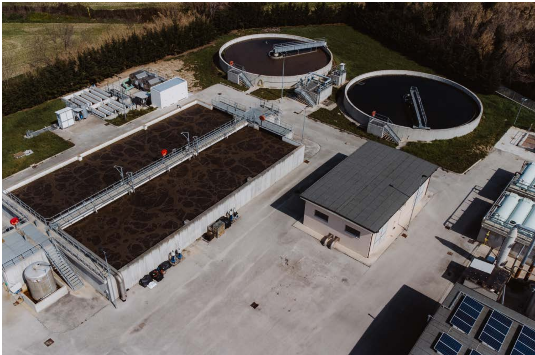
A fianco: tecnico del servizio depurazione. In alto: impianto di depurazione Basso Tenna, Fermo.
