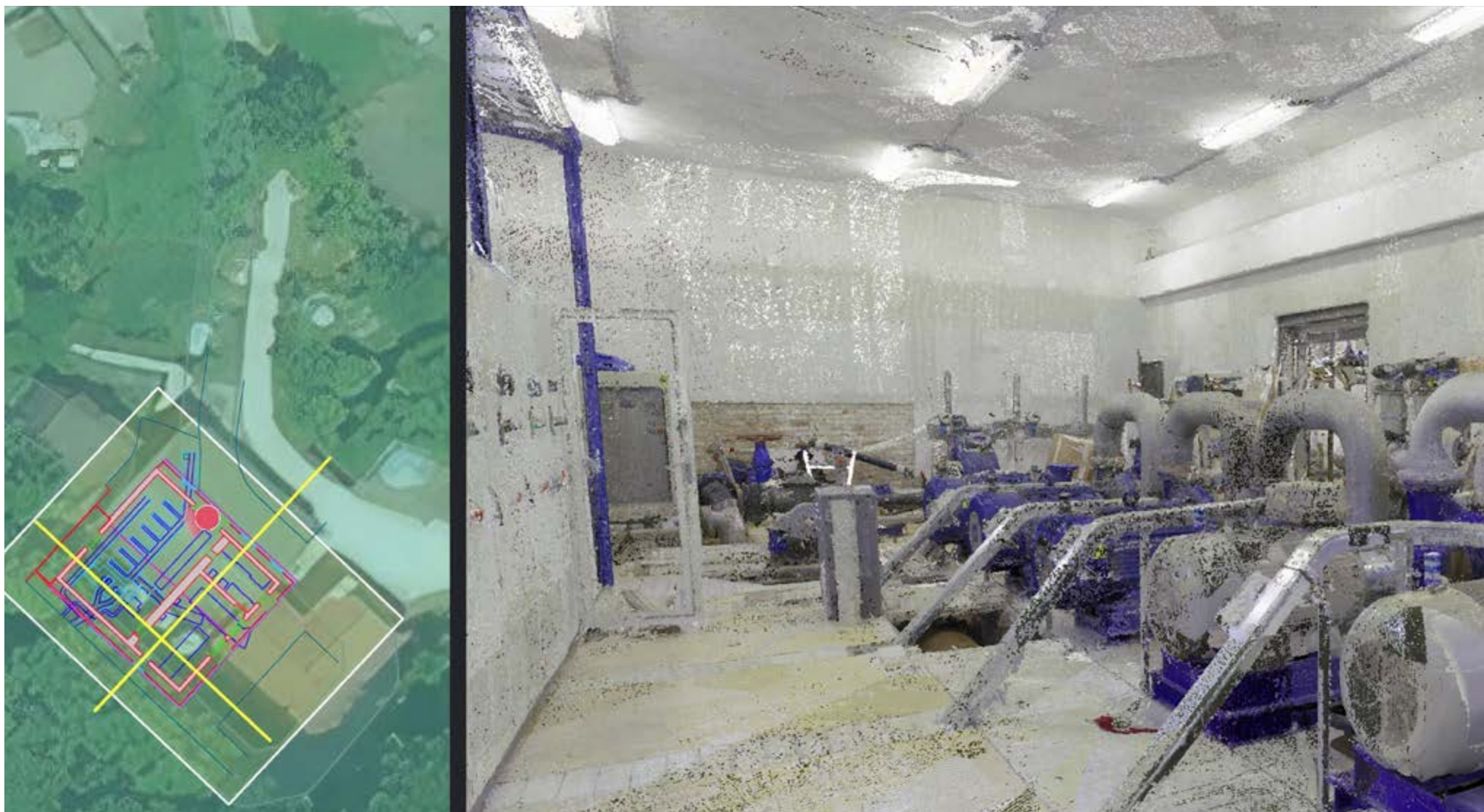
Rilievo con tecnologia laser scanner (nuvola di punti) del sollevamento idrico di Capodacqua
