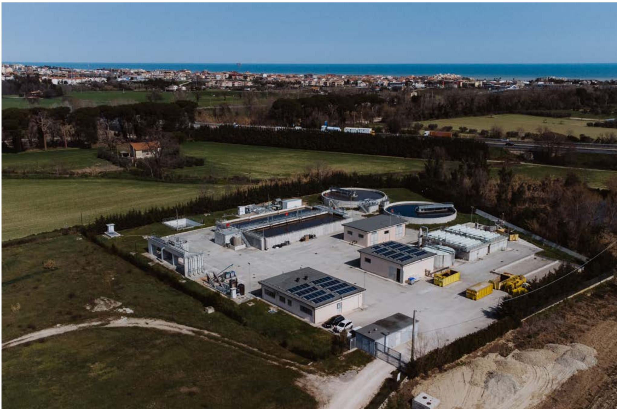
Impianto di depurazione Basso Tenna, Fermo.
