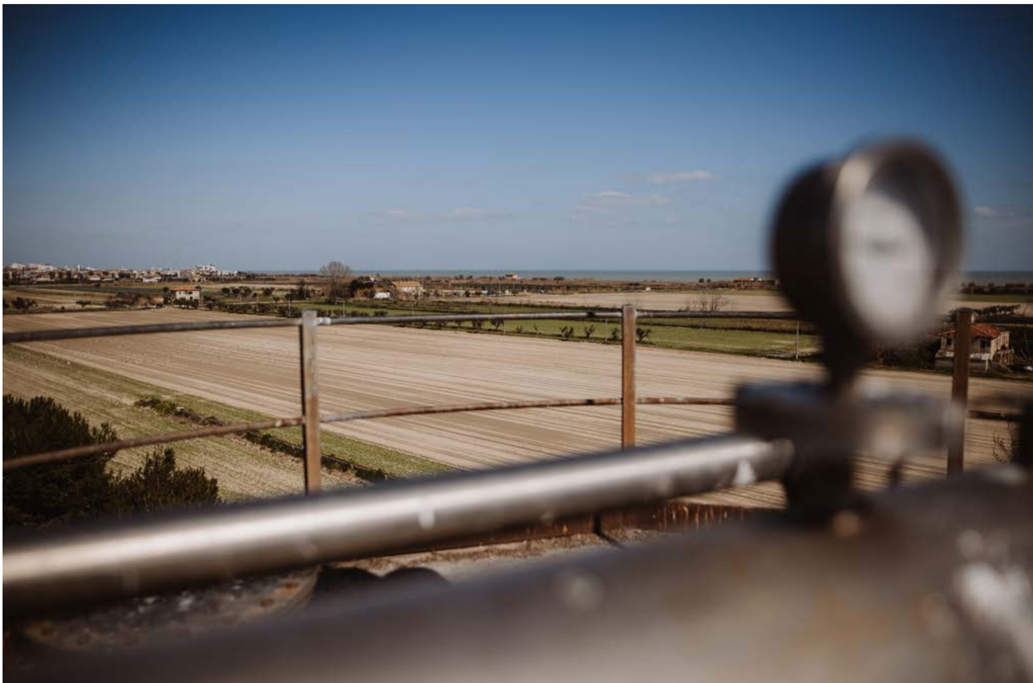
A fianco: tecnico operativo del servizio depurazione. In alto: vista panoramica dall'impianto.
